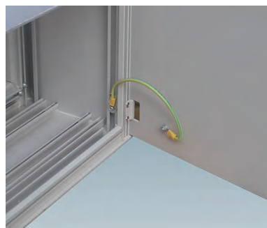
后开门与箱体的电气连接
