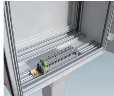
箱体内安装接线端子
